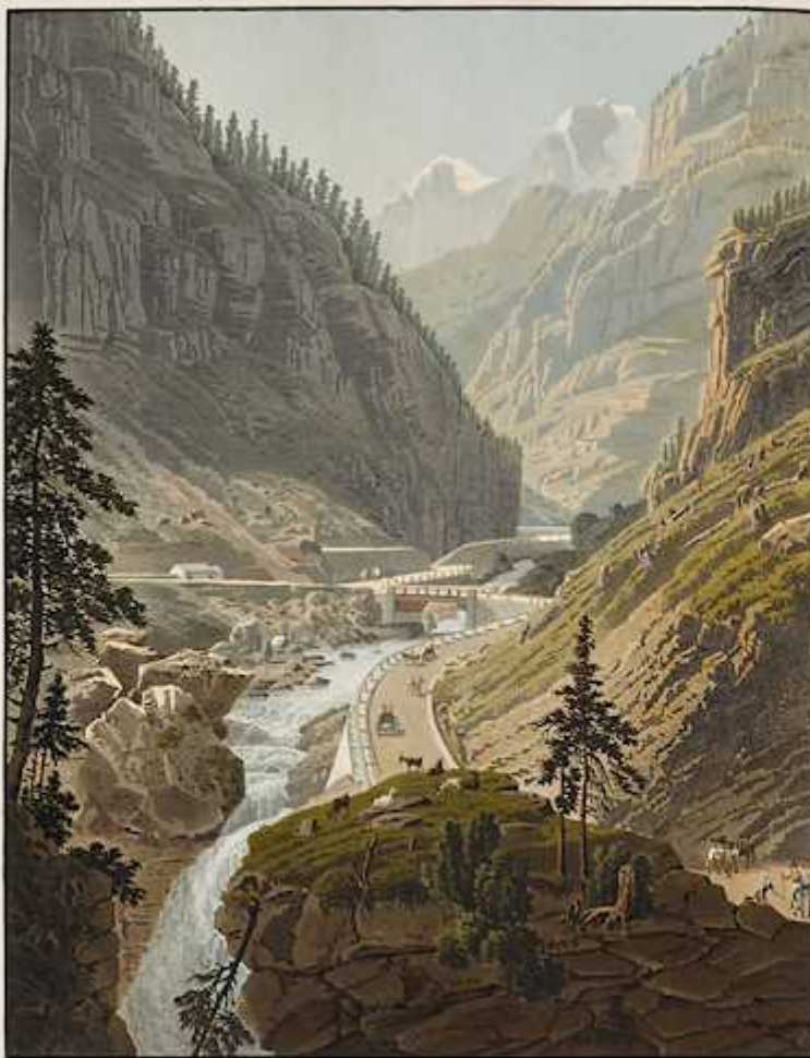
VUE DE LA NOUVELLE ROUTE PRÈS LA GRANDE GALERIE.
