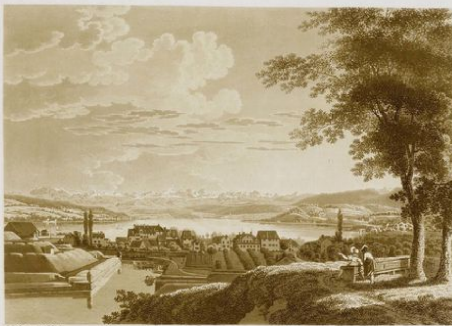
VUE DU LAC DE ZURICH prise du Bastion de la katze à Zurich.
